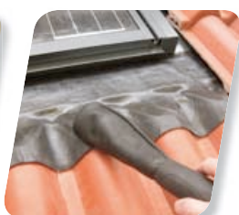
09 Installation de la bande de solin inférieure
