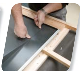
08 Installation de la bande de solin supérieure
