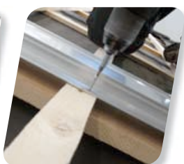
03 Fixation des rails
