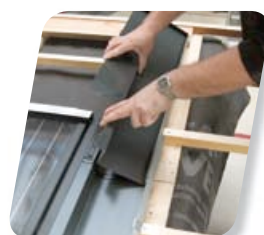
06 Installation des capotages et des bandes d'aluminium
