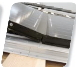
04 Installation et connexion des modules photovoltaïques
