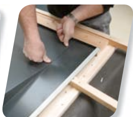
08 Installation de la bande de solin supérieure
