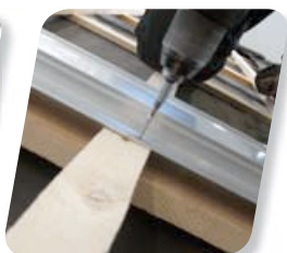
03 Fixation des rails
