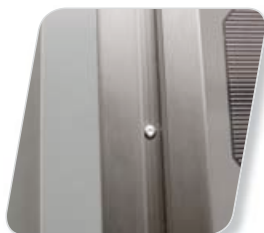
01 Marquage des positions pour les rails de montage
