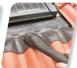
09 Installation de la bande de solin inférieure
