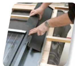
06 Installation des capotages et des bandes d'aluminium
